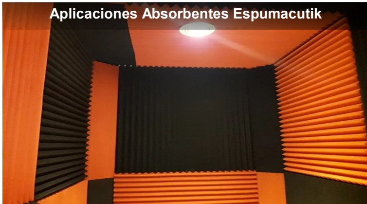
Tratamiento Acústico mixto en plafón y muros
