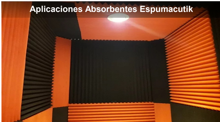
Tratamiento Acústico mixto en plafón y muros
